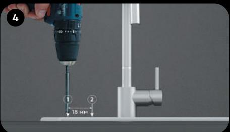
Просверлите 2 отверстия на расстоянии 18 мм от центра каждого из отверстий сверлом диаметром 12 мм.
